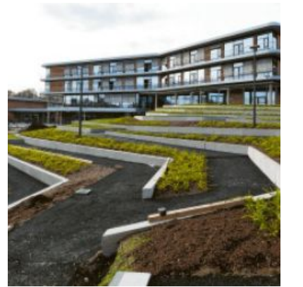
Mit den Arbeiten an den Außenanlagen soll der Neubau der Mittelschule 2021 abgeschlossen werden. Foto: Marcus Merk
